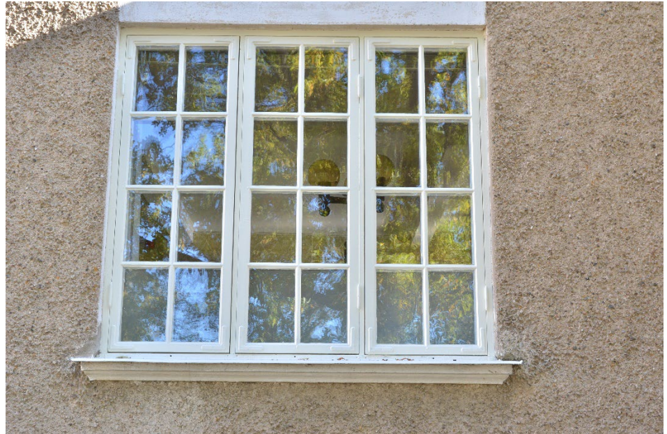
Bild 4. Fönsterbågar mot väster efter renovering (SLM D2022-0431).
