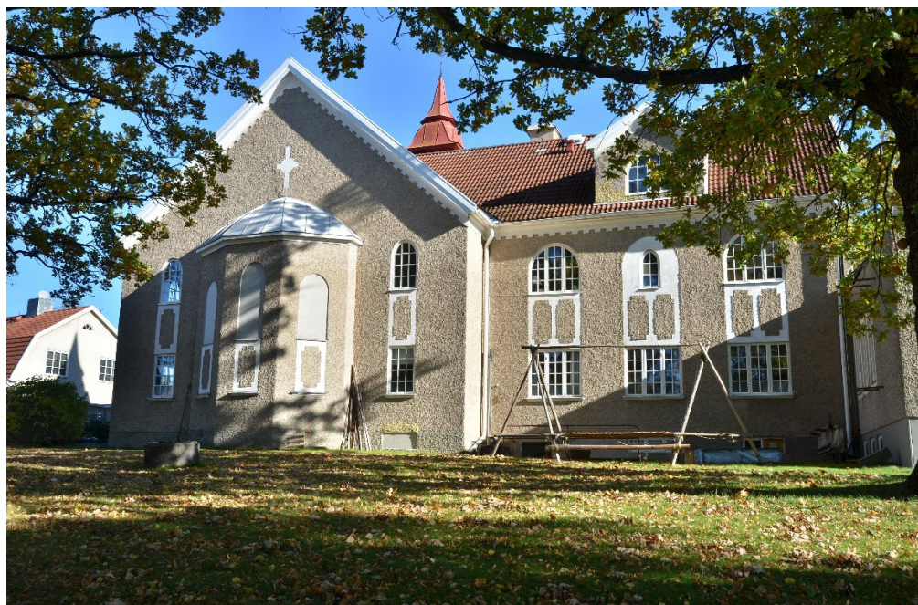
Bild 1. Västra fasaden, med "absiden" för koret i kyrksalen, efter utförd fönsterrenovering (SLM D2022-0430).
